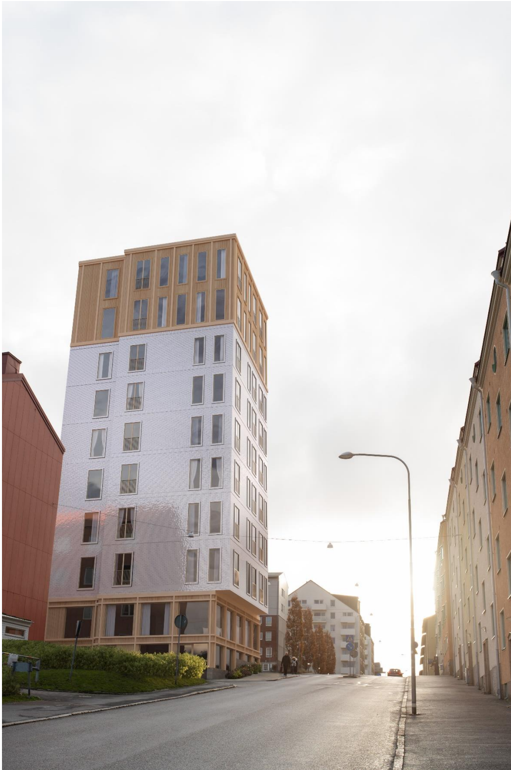
Figur 1. Vy från Ulf Sparregatan. Illustration Tengbom arkitekter. Markerad krona med sockel med träfasad för att få en varm och trevlig känsla, framförallt i gatunivå. Träfasaden detaljeras med dekorativt listverk. Ljust glaserat tegel för att passa in i områdets ljusa färgskala samtidigt som en ny årsring läggs till området. Det ljusa reflekterande materialet förbättrar ljusförhållandet i lägenheter som påverkas av försämrat dagsljus. Rak fönstersättning för att skapa rätta, horisontella och vertikala linjer. Högre våningshöjd samt uppglasade sockelvåningar för att skapa trygghet och liv i gaturummet. Här finns gemensamma ytor samt lokaler.
