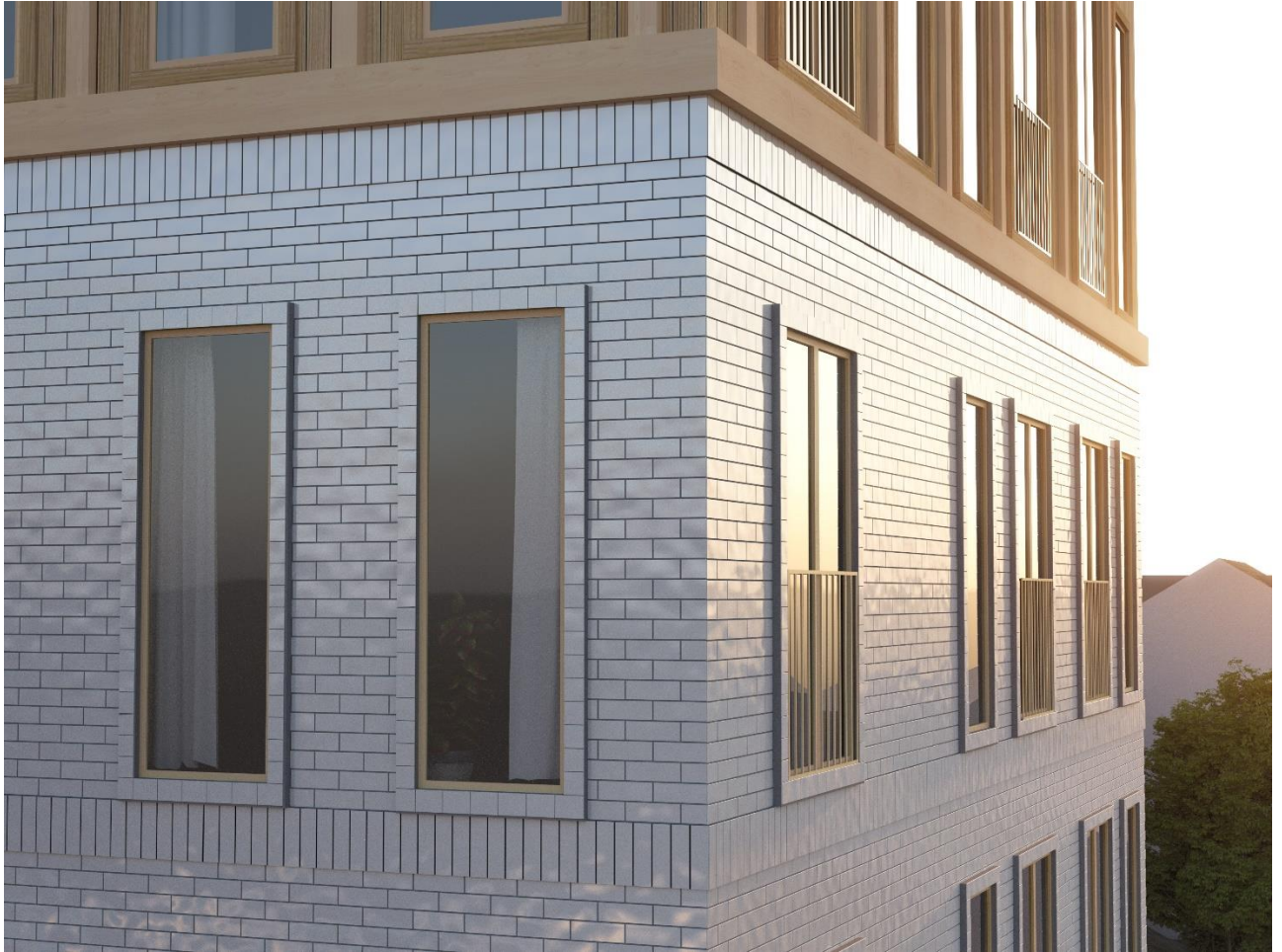
Figur 2. Illustration Tengbom arkitekter. Avslut och möten vid sockel och krona samt takfot bearbetas med friser för att skapa fina detaljer. Markerade fönster- och dörröppningar. Med utstickande fris av glaserat tegel. Smäckra balkongräcken utförs av ljusmetall.
